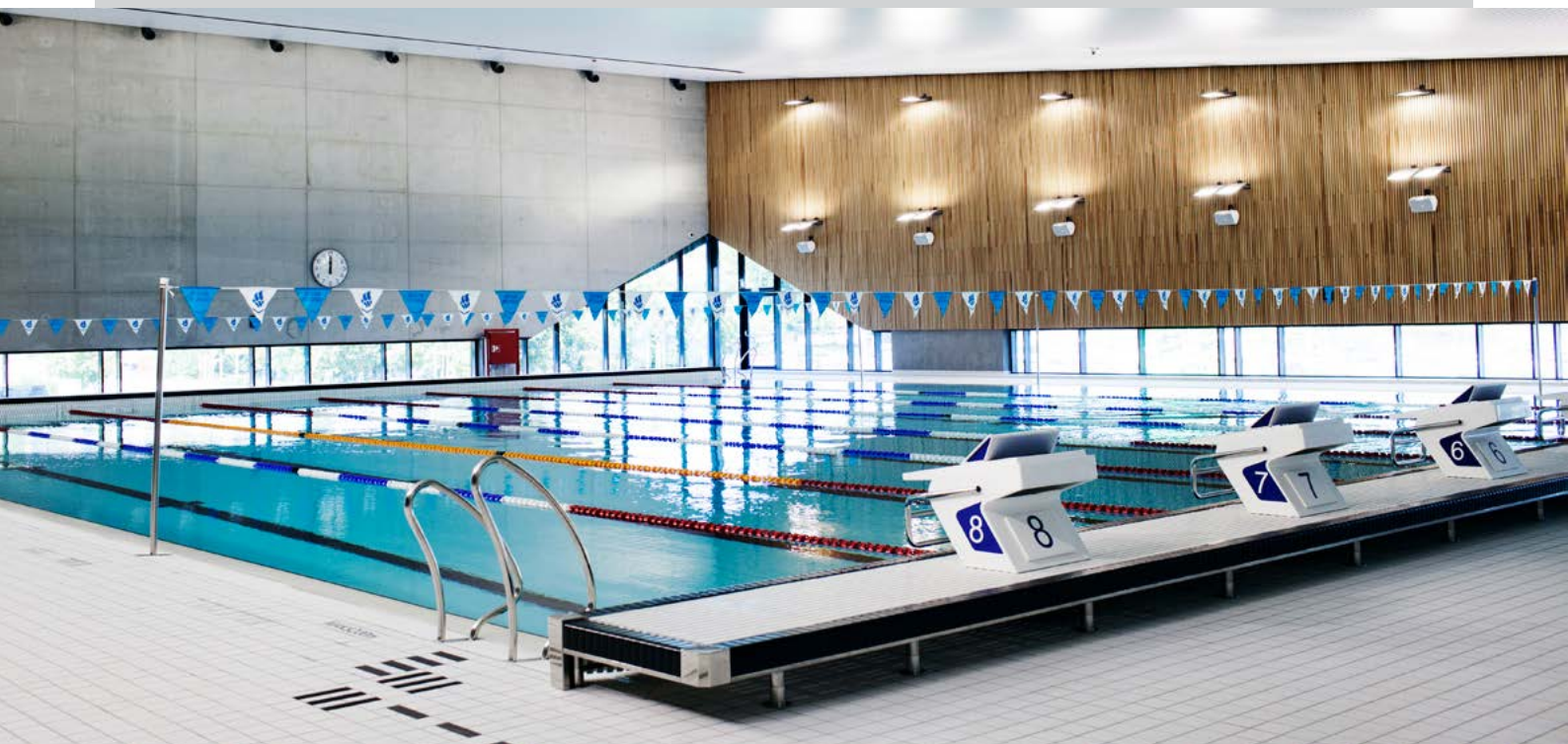
Holmen svømmehall i Asker har 25-meters lengdebasseng med åtte baner, badebasseng, treningsrom, kafé, og en park på taket med flott utsikt til fjorden. Som om ikke det var nok er det kanskje Norges mest miljøvennlige svømmehall. Foto: Torunn Brånå
