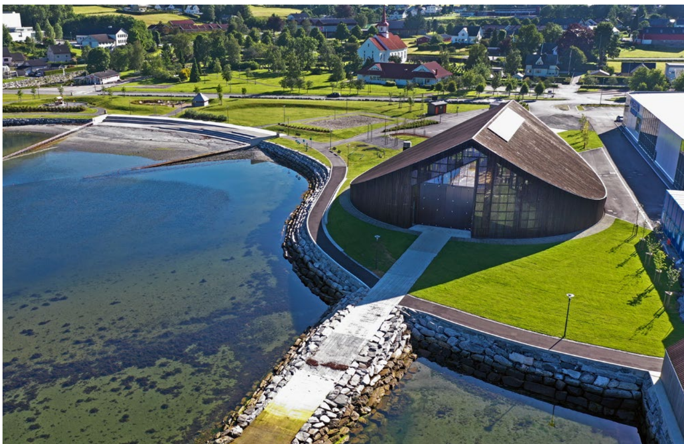
Sagastad vitensenter på Nordfjordeid er Vestlands nye kunnskapssenter om vikingtida. Bygget er oppvarmet med fjordvarme, har et sørvendt solcellepanel på taket, og sll belysning er LED. Til sammen gir dette et energieffektivt bygg som på varme, solfylte dager er selvforsynt med energi. Sagastad er finansiert med grønt lån fra KBN. Foto: Sagastad
